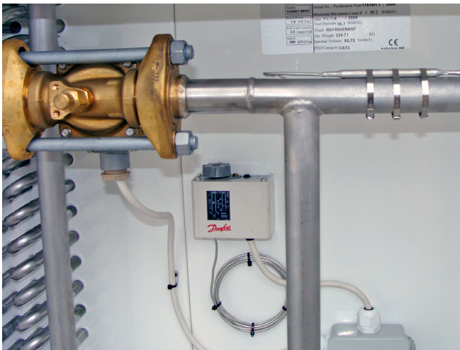
1'000 kg/Std. atmosphärischer ASCO CO 2 -Verdampfer Thermostat
