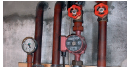
... und nach der Reinigung
