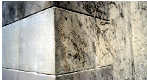
Steinfassade vor und nach der Reinigung
